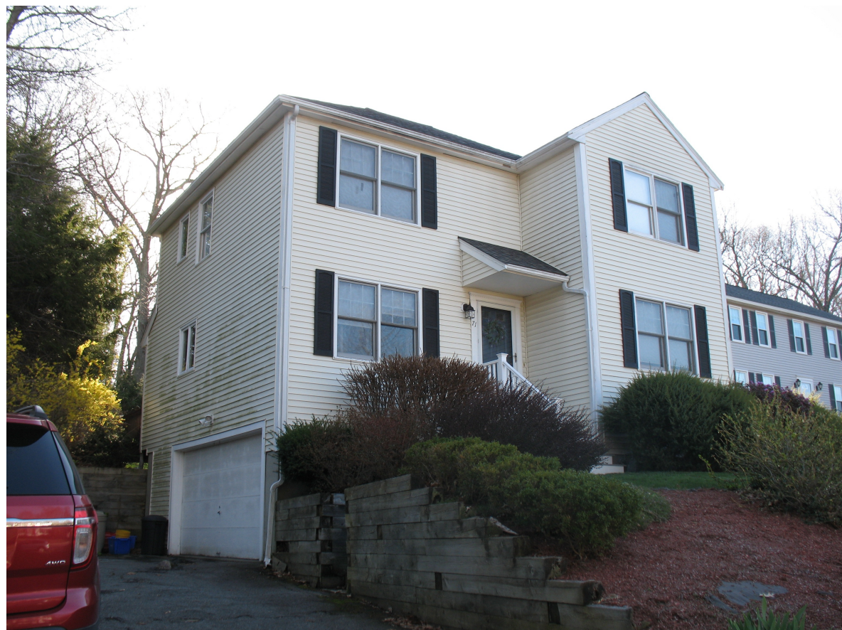
Photos of Existing Conditions Scale: N.T.S.
